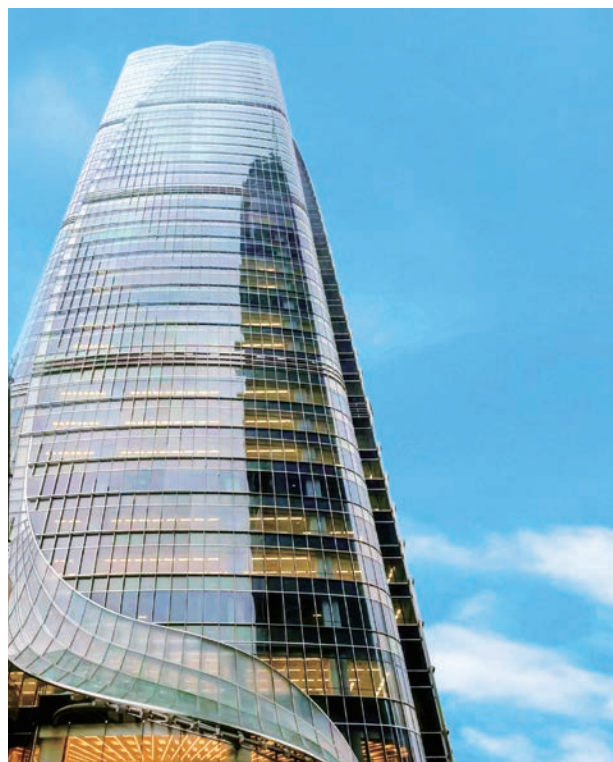
○ 上海市ITC樓高二百二十米的辦公大樓
