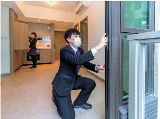
○ 交樓前進行全面檢查，以確保質素
