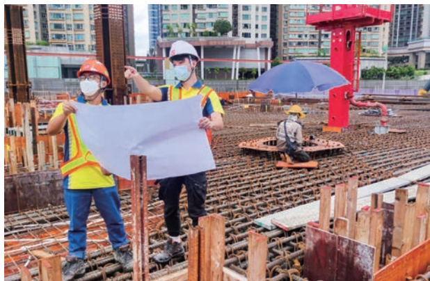
○ 高度重視保持高水平施工質量
