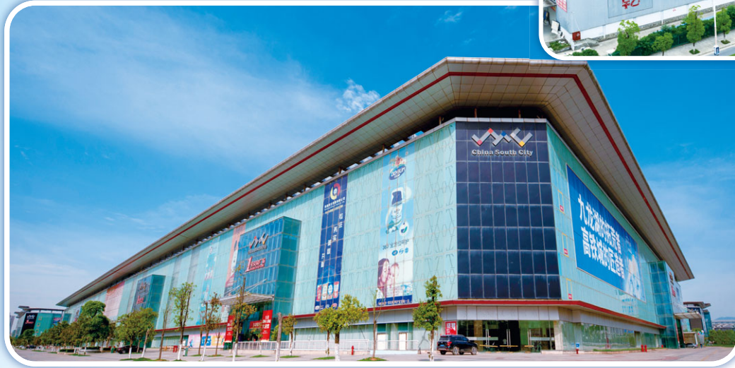
Trade Centre Plaza No. 1 in CSC Nanchang 南昌華南城的1號交易廣場
