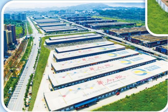
Qianlong Logistics Park in CSC Chongqing 重慶華南城的乾龍物流園區
