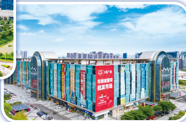
Trade Centre Plaza No. 3 in CSC Nanning 南寧華南城的 3號交易廣場
