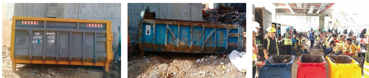
工地分類和回收廢物
