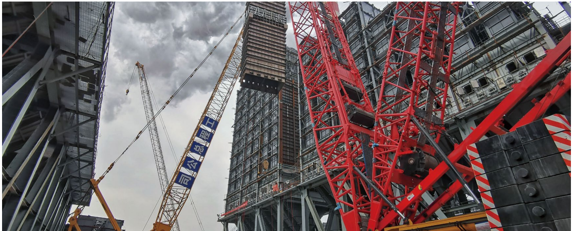
陝鋼集團漢鋼 2×265 m 2 燒結煙氣綜合治理提升改造項目
