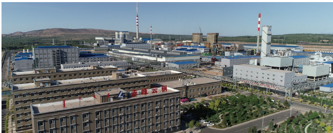
赤峰雲銅有色金屬有限公司環保升級搬遷改造項目
