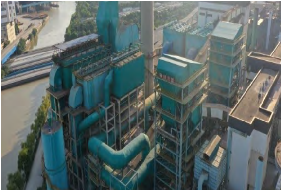
360m 2 烧结机头脱硫脱硝
