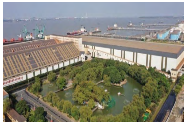
原料堆场封闭
