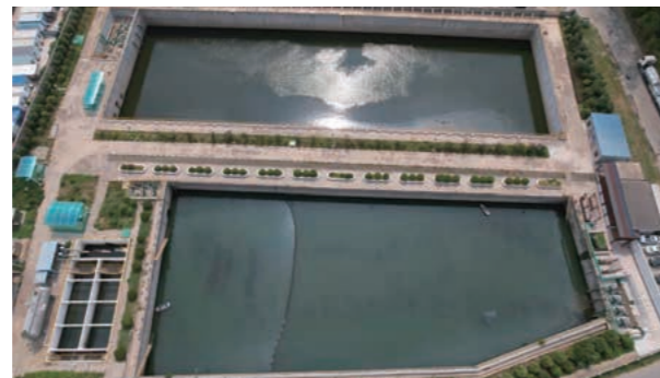
设立沉淀池，减少废水排放
