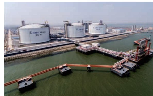
中国石化天津液化天然气 (LNG) 项目
