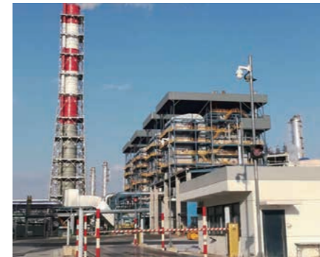
镇海基地一期动力中心锅炉成功应用多种化工尾气综合利用技术
