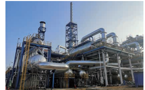
采用低排放硫磺回收工程设计技术的福建联合石化 180 kt/a 硫磺回收装置
