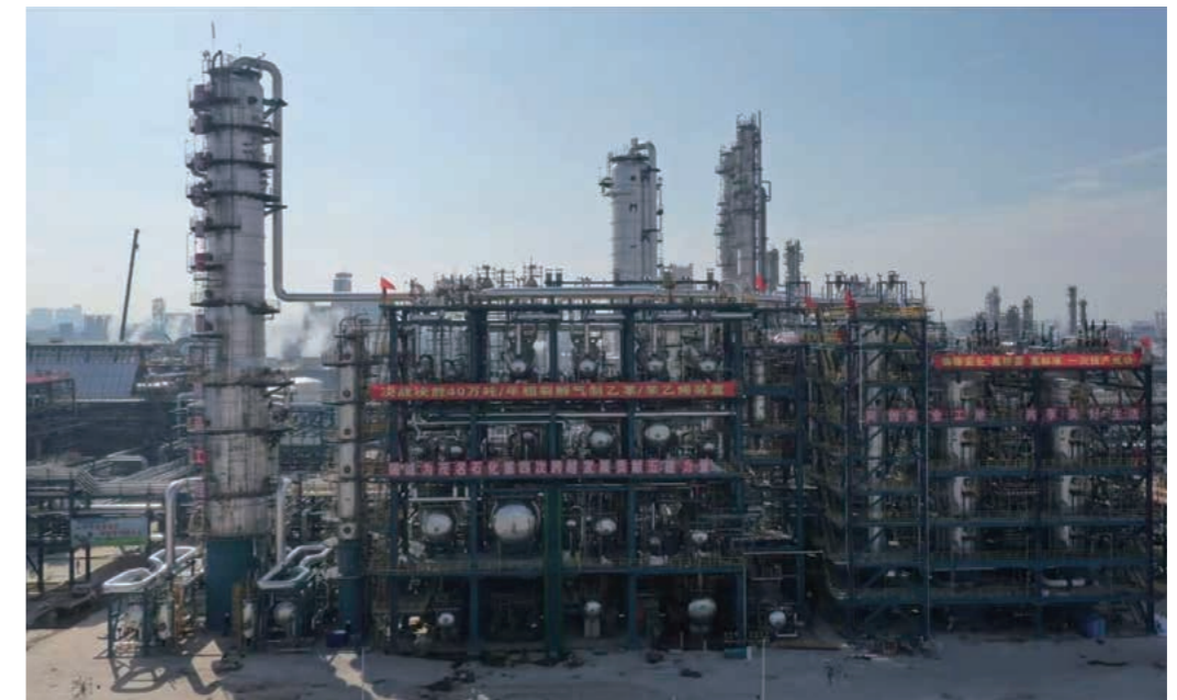
茂名低成本乙烷裂解气制乙苯 / 苯乙烯项目装置
