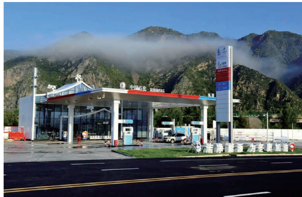
工程建设公司建成西湾子冬奥加氢站
