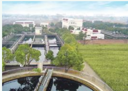
Jiangyin Waste Water Treatment Project 江陰污水處理項目
