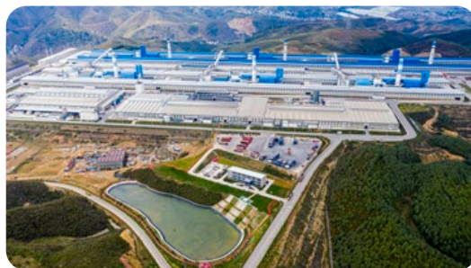
雲鋁海鑫水電鋁一體化項目建設
