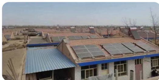
屋頂光伏建設
