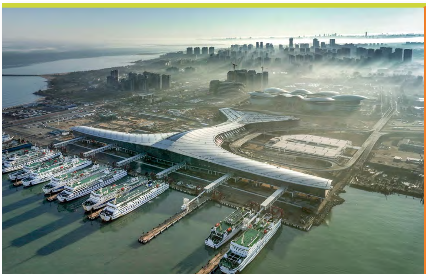
本行積極助力海南自貿港建設，提升基礎設施配套水平，開闢綠色通道有效推動航空、機場、港口、電力及燃氣、公交等基礎產業發展
