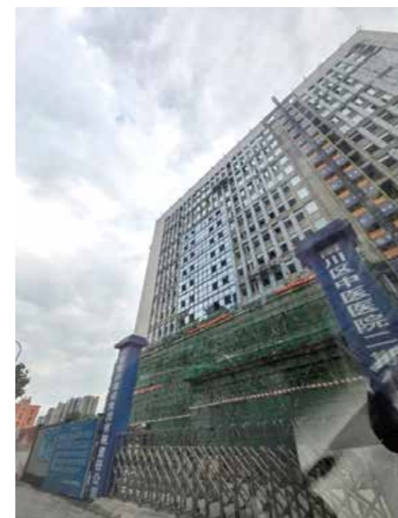
南川區中醫醫院二期工程
