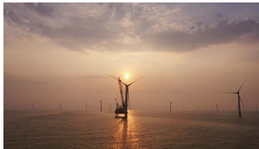
公司勘察設計的中廣核汕尾甲子900兆瓦海上風電場
