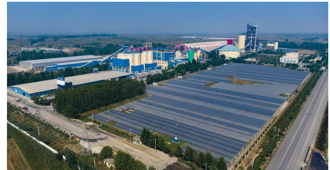
臨沂中聯6.5兆瓦分佈式光伏並網電站
