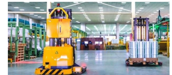
中國巨石「未來工廠」智能化設施
