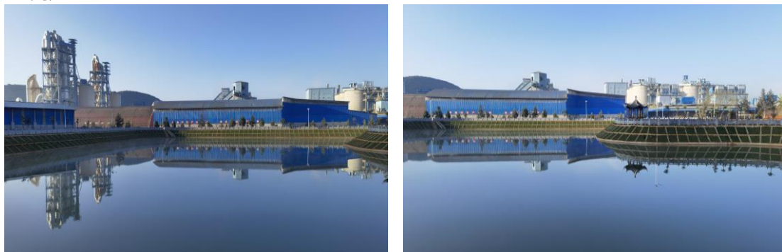
雲南興建水泥雨水收集循環水池項目
