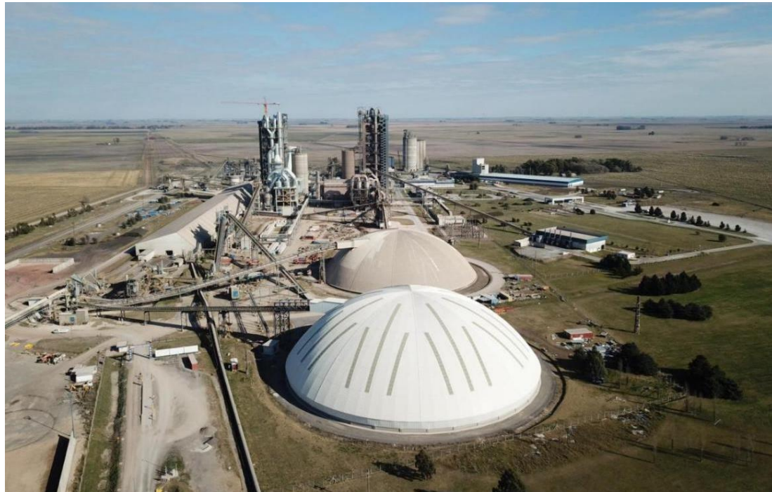
中材國際阿根廷L' AMALI二線5800TPD水泥生產線
