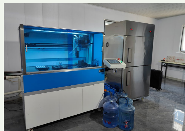
精準碳源投加系統和精準化學除磷投加系統已在項目公司正式投用
