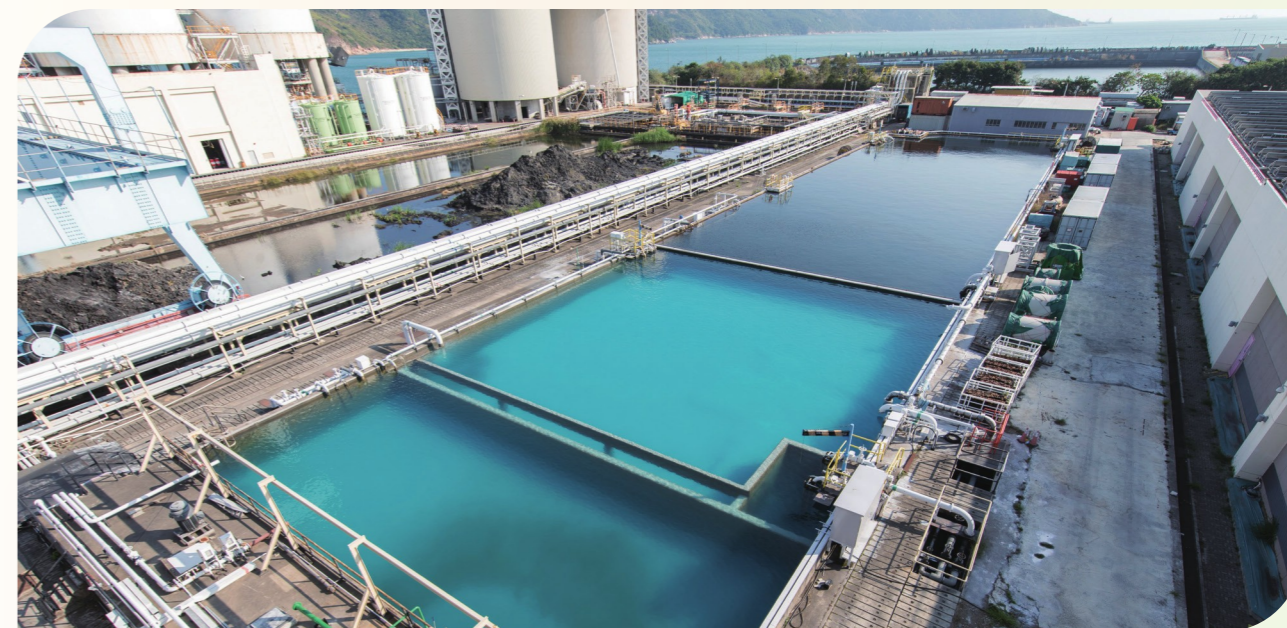
南丫發電廠將收集得來的雨水和工廠廢水循環再用。
