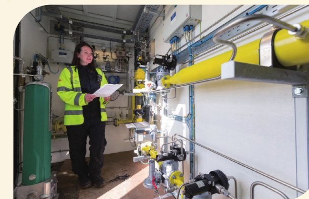
WWU員工檢查生物甲烷站點的連接情況，確保可以為網絡供應可再生氣體。
