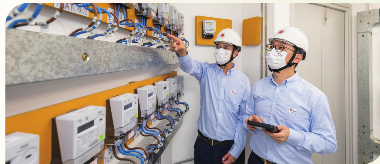
港燈為客戶安裝智能電表，方便落實能源管理。
