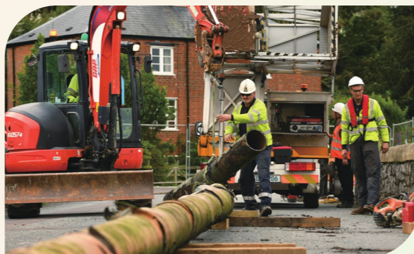
工人們更換老舊的天然氣管道，以減少氣體洩漏造成的排放。
