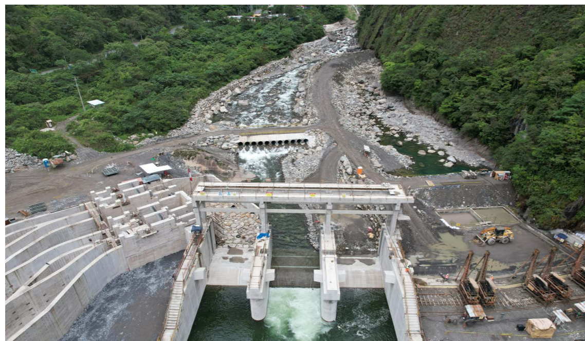
三峽集團祕魯聖加旺水電站建設工程
