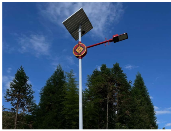
雲南省德宏州分公司在駐點村安裝太陽能路燈
