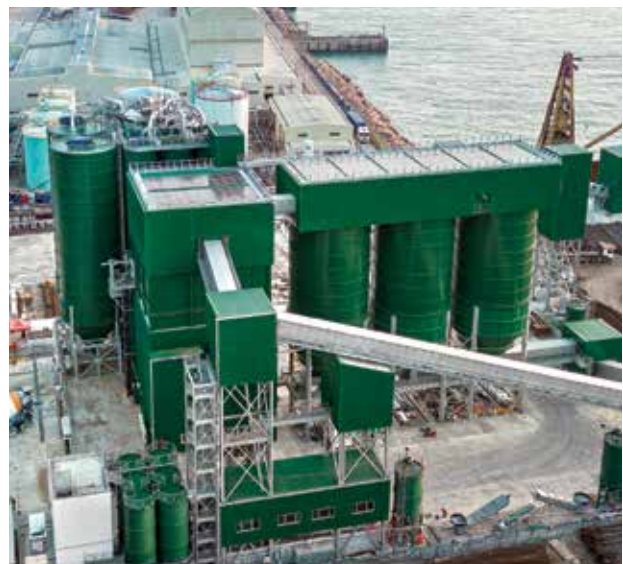
於二零二二年十二月，友盟在香港新建的茜草灣二大型混凝土廠房開始全面營運。
