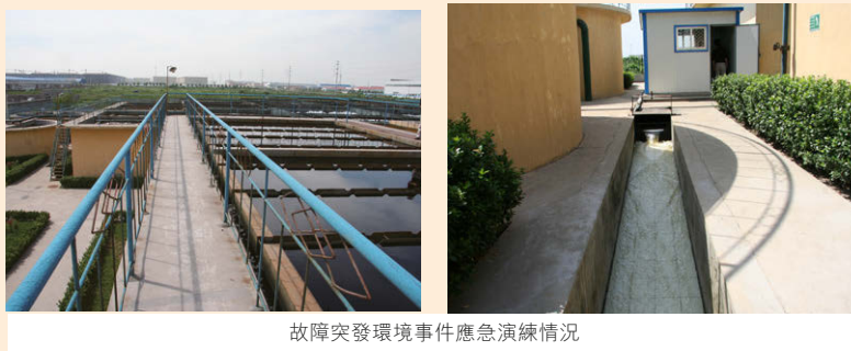
山東宏勝紡織有限公司牛仔布污水處理廠設備
