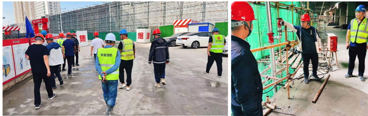
安全檢查現場
