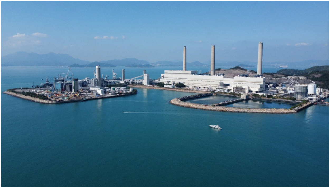
港燈在南丫發電站的燃氣生產機組
