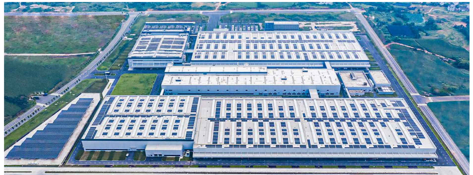
廠房光伏設備
