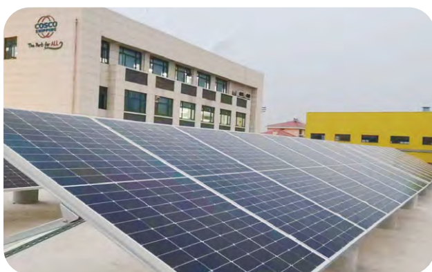
CSP武漢碼頭在港區內5,768平米屋頂 安裝1,063塊功率545WP單晶硅太陽能光伏組件， 設計裝機容量0.578MWP， 為港口生產提供清潔電力。
