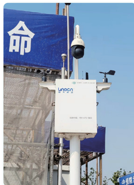
在建築地盤安裝分貝測量儀，監控噪音水準，每日進行數次隨機檢查，不定時記錄度數。
