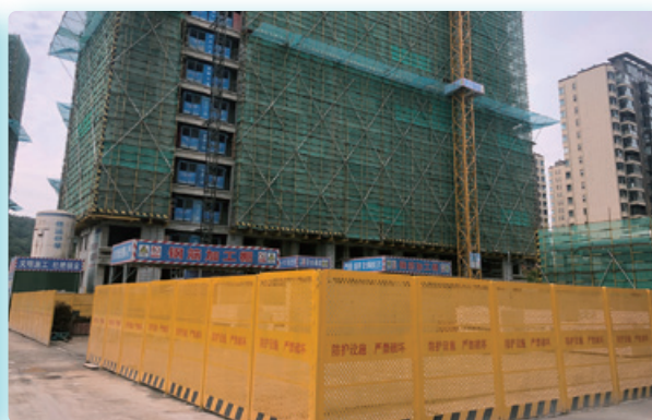
設置穩固欄桿等防護設施以保護工人施工安全實例。
