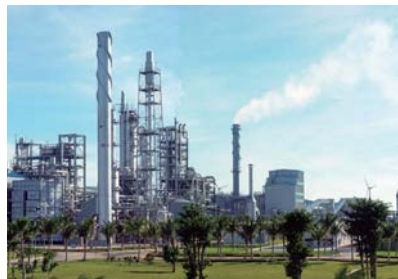
海南生產裝置
