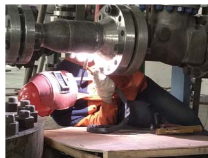
參與現場設備改造
