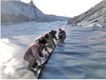
華鶴煤化工采坑防滲膜鋪設
