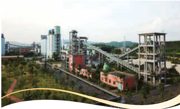
廣東韶鋼嘉羊新型材料有限公司 位於廣東省韶關市的礦渣微粉生產廠房
