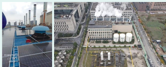
余杭新奧燃氣公司分佈式光伏發電系統
