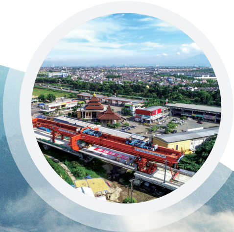
印尼雅萬高鐵 四號梁場
