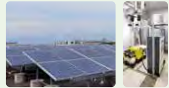
圖：光伏發電、中水回用裝置
