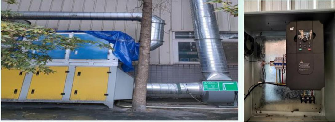
我們於 2022 年新購置 PLC 空氣淨化裝置以專治 VOCS 排放。設備安裝後，有機廢氣排氣筒出口相關排放濃度遠低於濃度限制，極大地控制了廢氣排放總量。
