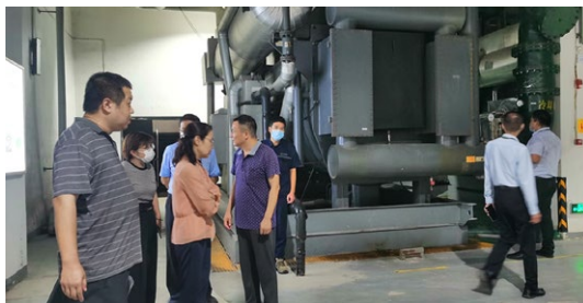
安全檢查現場
