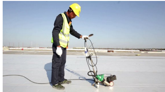
防水保溫一體板施工現場
