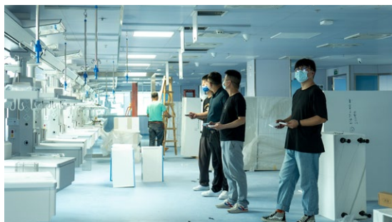
開關改造現場
