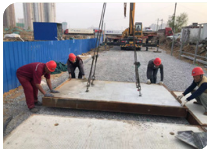
鋪設石子墊層及預制路面
