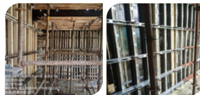
濮陽城市天築項目傳統模板採用型鋼加固體系
