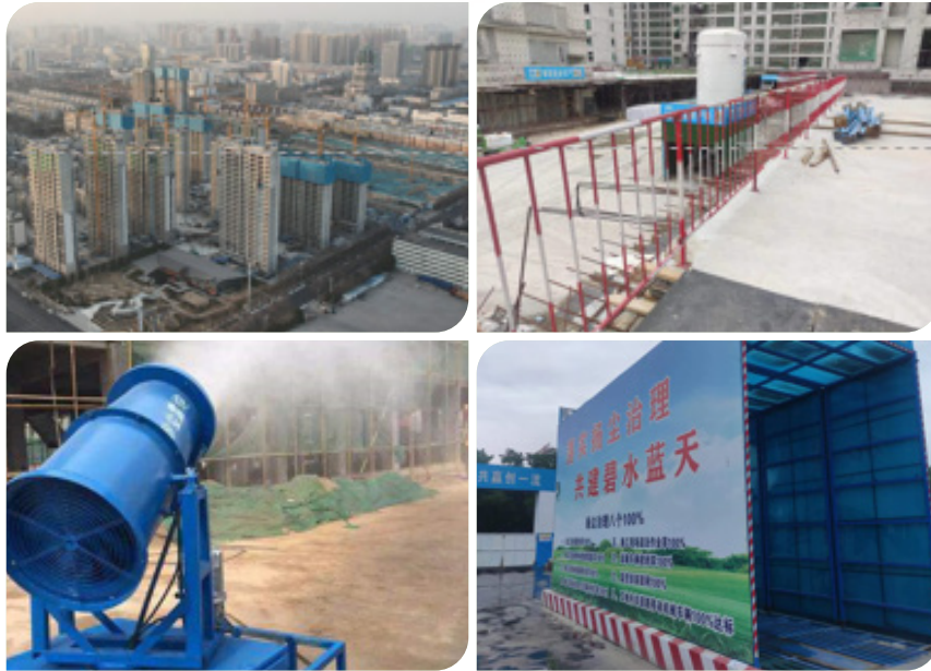
新飛建業府綠色示範工程照片
