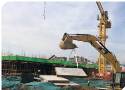
預制路面吊裝
