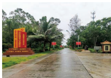
Road repair 道路修復
