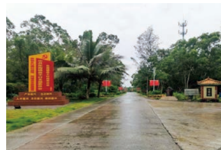
Road repair 道路修復
