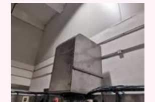
設備安裝隔音罩
