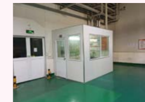
車間安裝隔音室
