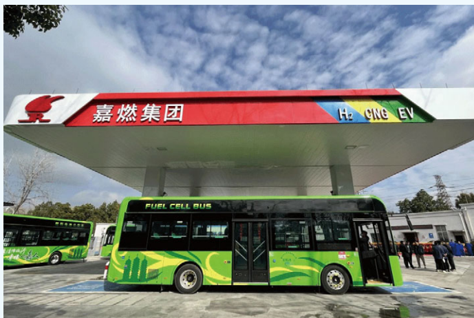
圖：崗山路綜合能源站
