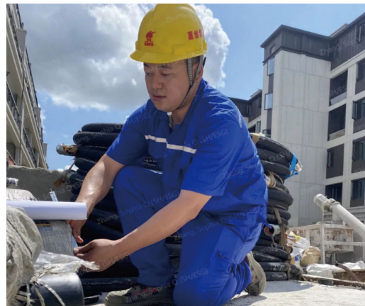
圖：現場管材驗收
