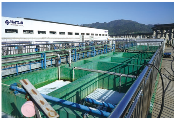
廢水處理站屋頂處理池
