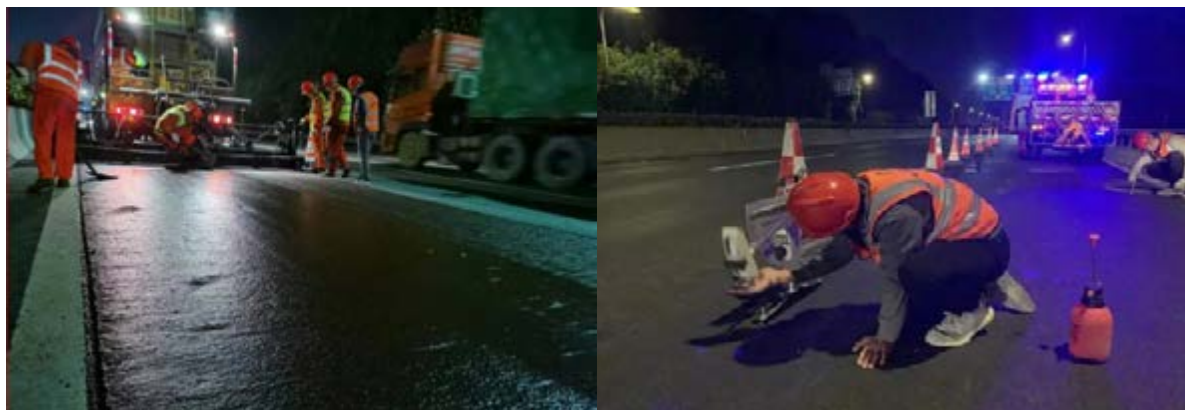
高粘高彈改性乳化瀝青在北二環高速進行應用鋪築
