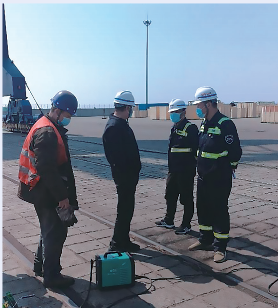
圖：電氣安全專項檢查
