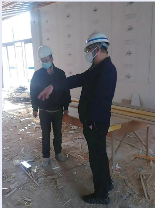
圖：建築施工安全專項檢查
