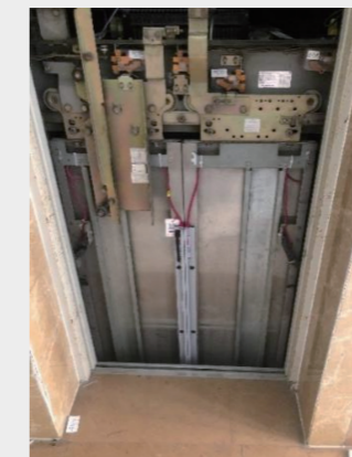
光幕式電動車阻車器安裝圖
