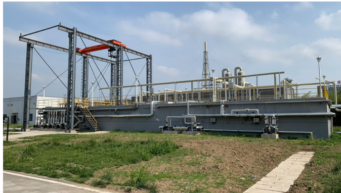
新建污水收集及處理系統
