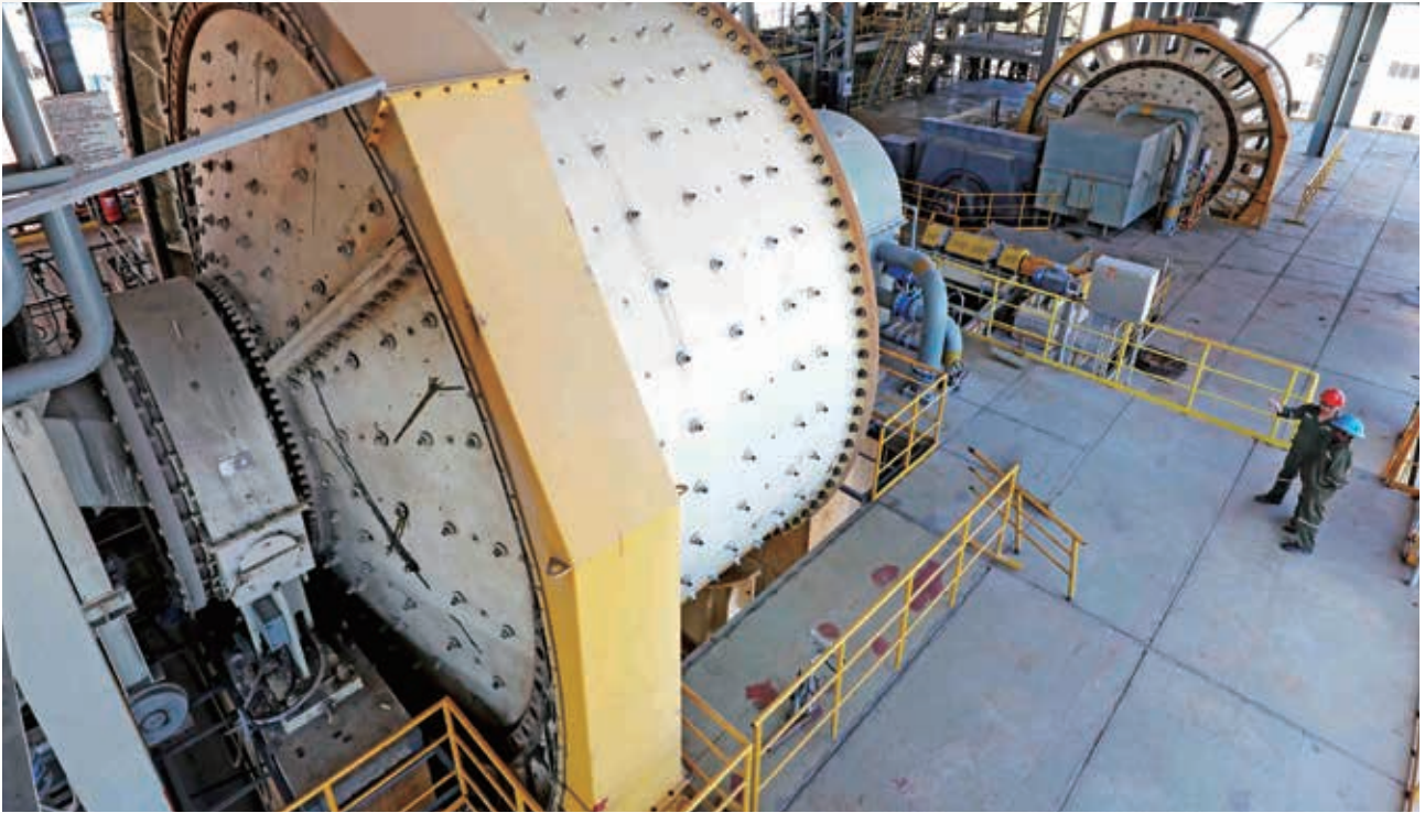
中色非礦東南礦體先進選礦工藝設備
