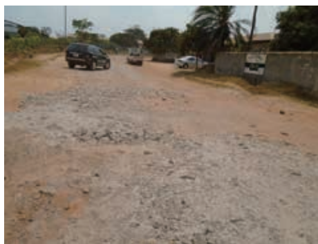
使用碎石填平道路後
