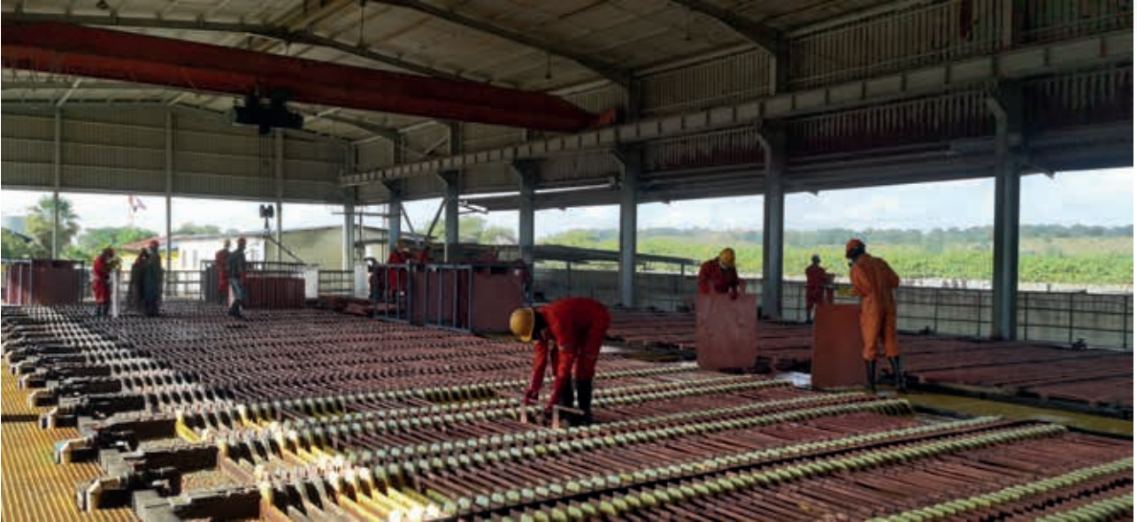
謙比希濕法萃取電積車間生產現場
