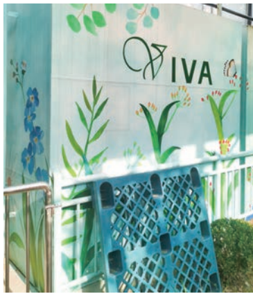
法拉第路園區新增水處理設施
