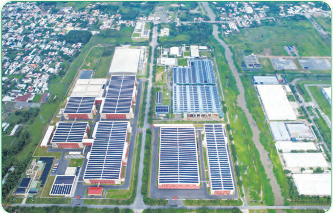
越南廠區的太陽發電板 PV panels in the Vietnam factory
