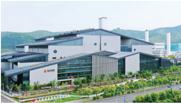
Suzhou Waste-to-energy Project 蘇州垃圾發電項目
