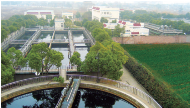
Jianguyin Waste Water Treatment Project 江陰污水處理項目
