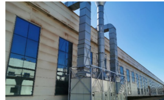
图：新增或改造焊煙除塵系統
