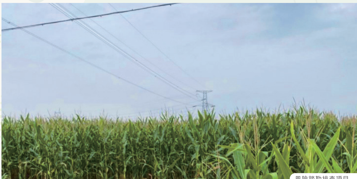
風險踏勘排查項目
