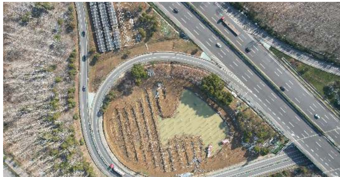
合肥绕城高速南环段光伏项目
