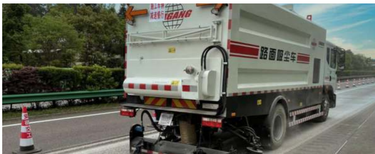
施工现场无尘清扫
