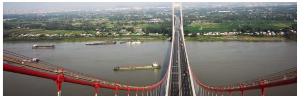
马鞍山长江公路大桥主缆
