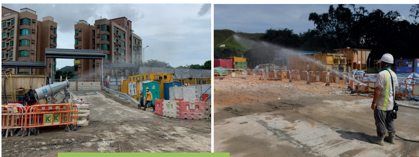
建築工地的塵埃管控措施
