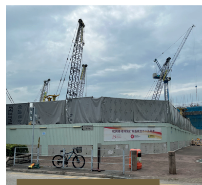
於工地安裝隔音屏障
