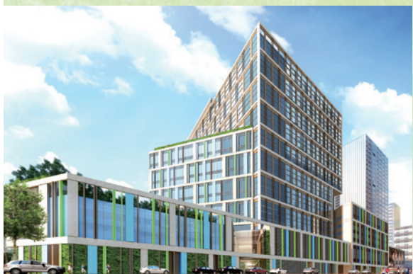
廣華醫院重建項目第一期上蓋工程
